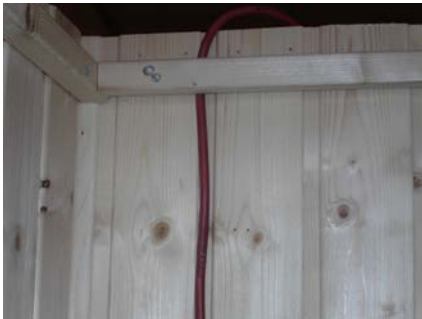
Kabel eingezogen Abb. 21 a
