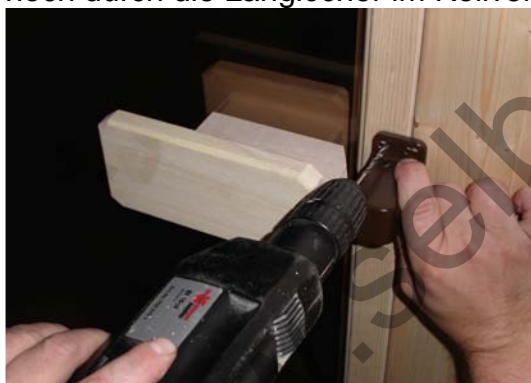
Abb. 18 Rolle unter Spannung leicht anbohren
