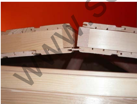
Abb. 22 Dächer mit Feder angehoben
