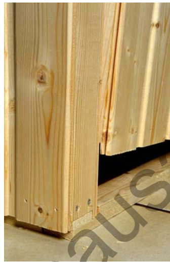
Abb. 8 Element gegen Element stoßen
