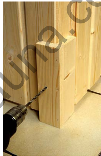
Abb. 9 Vorbohren mit Bohrschablone
