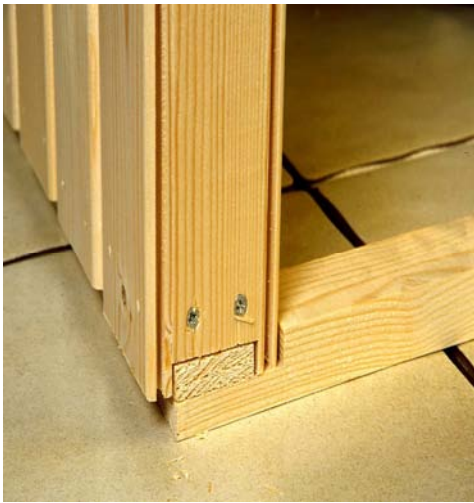
Abb.7 Element auf Grundrahmen glatte Seite zur Ecke
