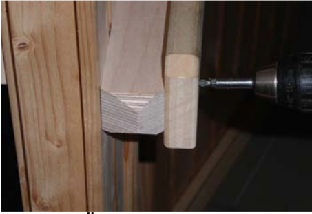
Abb. 19 Äußerer Türgriff bündig mit Türaußenkante
