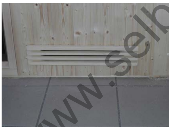
Abb. 30 Zuluftgitter festgeschraubt
