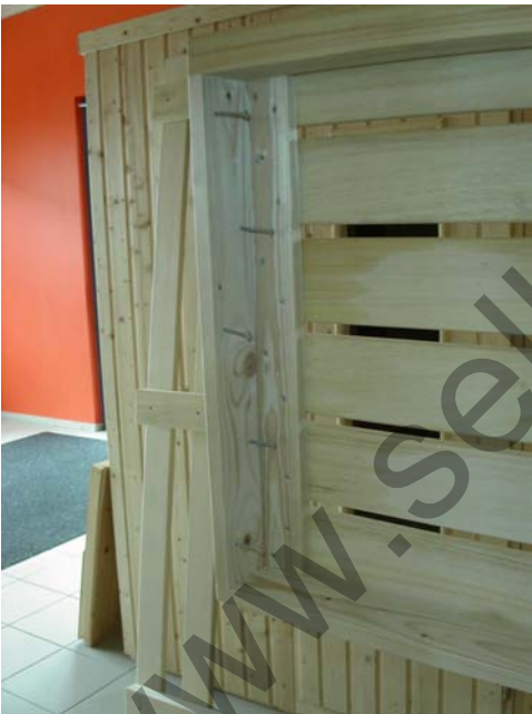
Abb. 27 Versetzte Schrauben der zusätzlichen Liege
