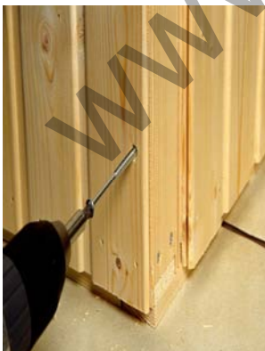
Abb. 10 Verschrauben der Elemente
