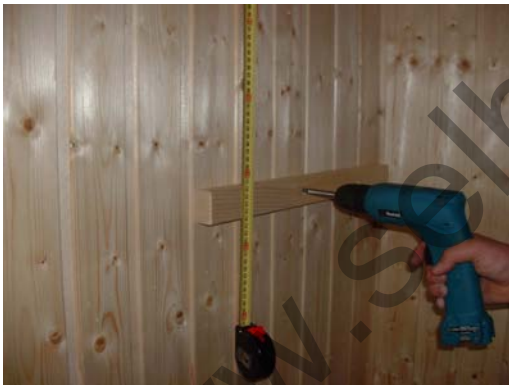
Abb. 25 kurze obere Liegeauflageleiste verschraubt
