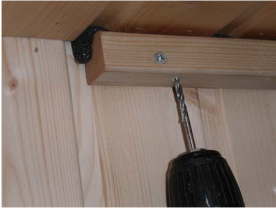
Abb. 24 Dachauflageleiste mit Dach verschrauben nach Vorbohren
