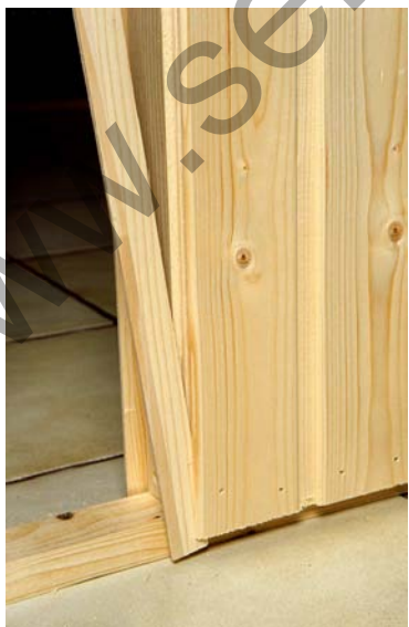
Abb. 12 Feder eingesteckt 6 mm Vorsprung sichtbar
