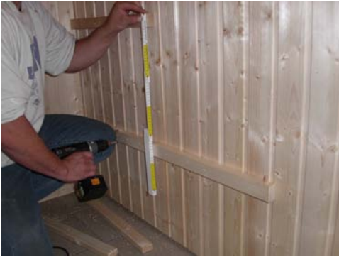
Abb. 26 lange untere Liegeauflageleiste verschraubt
