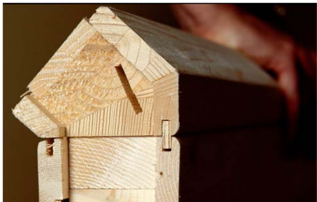
Abb.14 Eckpfosten auf Zuluftelement geschraubt (Ansicht von oben)
