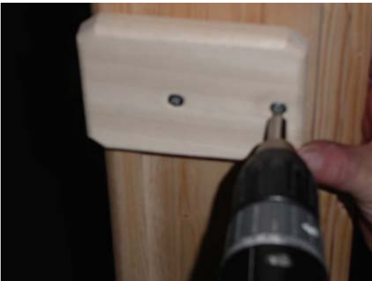
Abb. 20 innerer Griff mit Versprung gegen Glasleiste gesetzt |
