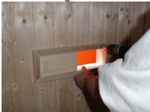
Abb. 29 Abluftschieber festgeschraubt
