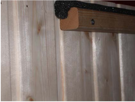
Abb. 21 Dachauflageleiste mit Dichtband
